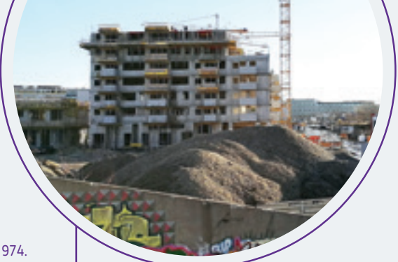
Baustelle an der Bruno-Marek-Allee
